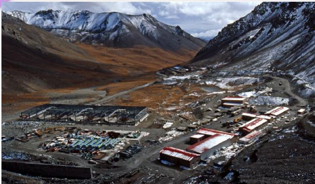
智博铁矿矿山建设
